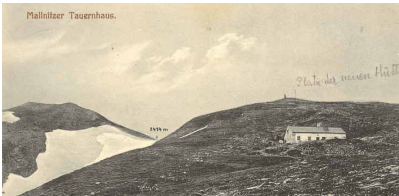
Historische Ansicht des Tauernhauses am Übergang nach Salzburg.
