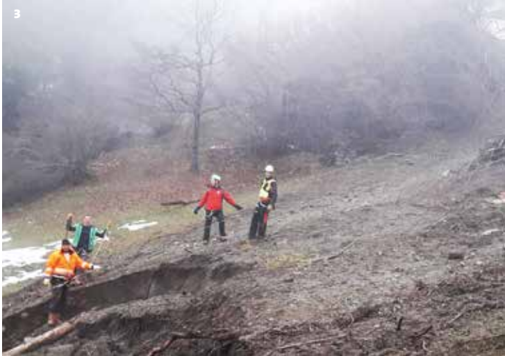
3 Bergretter sichern in Obervellach zwei Arbeiter, die oberhalb eines Hangrutsches Grabungen durchführten, um die Wasserversorgung eines Bergbauernhofs zu reparieren.
