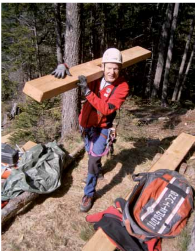
Erich Geir beim Bau des Klettersteigs im Bergsteigerdorf St. Jodok.
